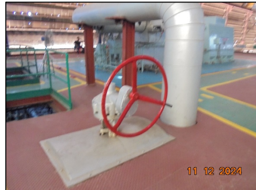
รูปที่ 78 ติดตั้งลิ้นนิรภัย และวาล์วควบคุม (Control Valve)
