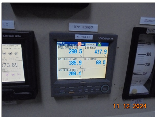
รูปที่ 77 ตรวจวัดอุณหภูมิและความดันทั้งขาเข้า-ขาออกจากกังหันไอน้ำ
