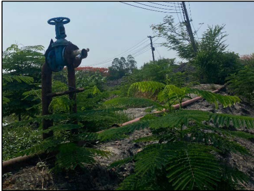
รูปที่ 87 Hydrant และสายฉีดน้ำดับเพลิงรอบลานกองขาน้อย
