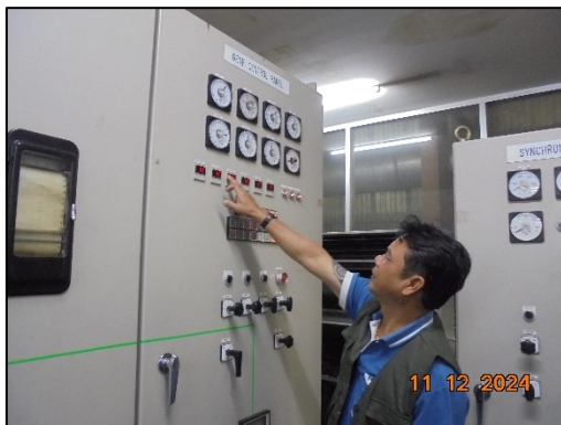
รูปที่ 76 อุปกรณ์ตรวจวัดต่างๆ เพื่อตรวจสอบการทำงานหน่วยผลิตไอน้ำ
