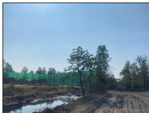
รูปที่ 10 ตาข่ายชะลอลมและดักฝุ่นรอบบริเวณลานกองเก็บขาน้อย
