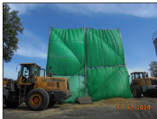
รูปที่ 10 ตาข่ายชะลอลมและดักฝุ่นรอบบริเวณลานกองเก็บขาน้อย
