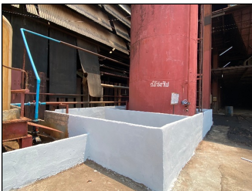
รูปที่ 75 คันคอนกรีตรอบบริเวณถังเก็บกากสารเคมีของเหลว
