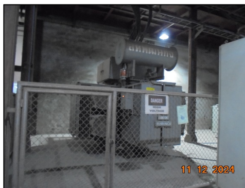
รูปที่ 81 หม้อแปลงไฟฟ้า
