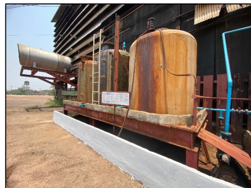
รูปที่ 75 คันคอนกรีตรอบบริเวณถังเก็บกากสารเคมีของเหลว
