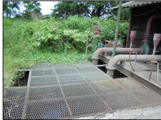
รูปที่ 37 ระบบรวบรวมน้ำเสียที่เกิดจากการฟื้นฟูระบบผลิตน้ำอ่อน
