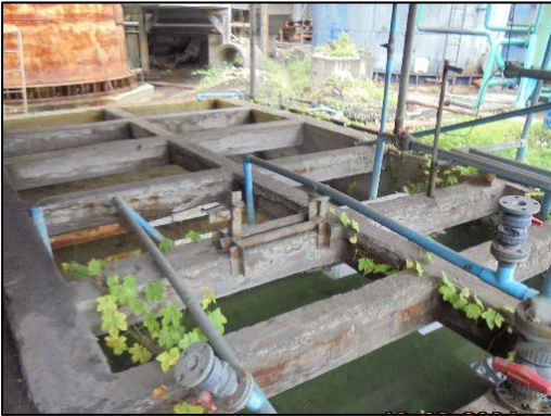
รูปที่ 37 ระบบรวบรวมน้ำเสียที่เกิดจากการฟื้นฟูระบบผลิตน้ำอ่อน
