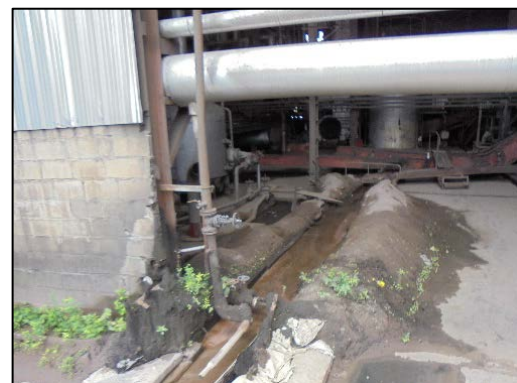
รูปที่ 47 รางระบายน้ำฝนที่ไม่มีโอกาสปนเปื้อน
