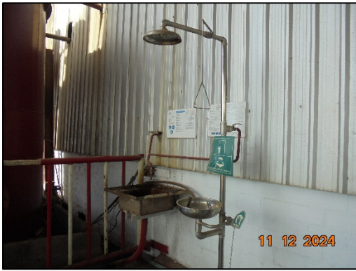
รูปที่ 73 อ่างล้างตา/ล้างหน้า ฝักบัวฉุกเฉิน
