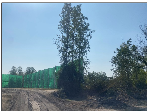
รูปที่ 10 ตาข่ายชะลอลมและดักฝุ่นรอบบริเวณลานกองเก็บขาน้อย
