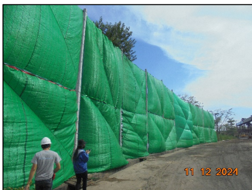
รูปที่ 10 ตาข่ายชะลอลมและดักฝุ่นรอบบริเวณลานกองเก็บขาน้อย
