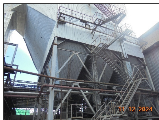
รูปที่ 3 เครื่องดักจับอนุภาคด้วยไฟฟ้าสถิต (Electrostatic Precipitator หรือ ESP)
