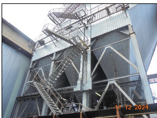
รูปที่ 3 เครื่องดักจับอนุภาคด้วยไฟฟ้าสถิต (Electrostatic Precipitator หรือ ESP)
