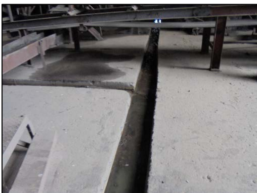
รูปที่ 47 รางระบายน้ำฝนที่ไม่มีโอกาสปนเปื้อน
