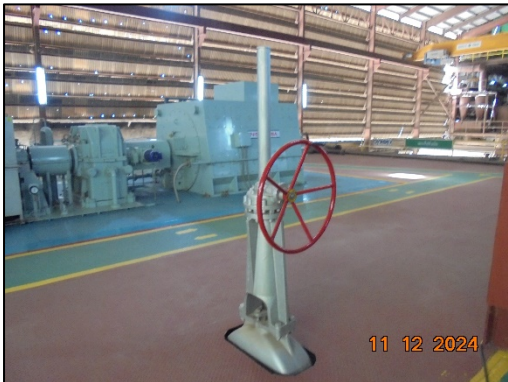
รูปที่ 78 ติดตั้งลิ้นนิรภัย และวาล์วควบคุม (Control Valve)
